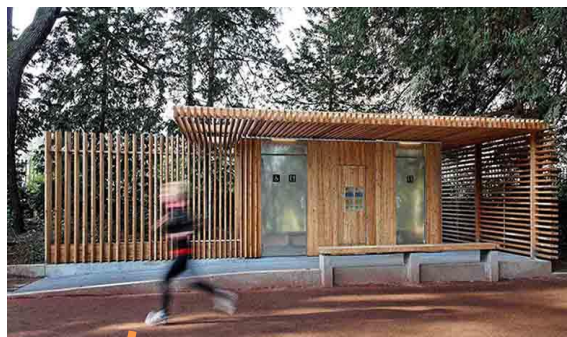
Figure 31 : Sanitaire public. Source : Parc de la Tête d'Or à Lyon (69)
